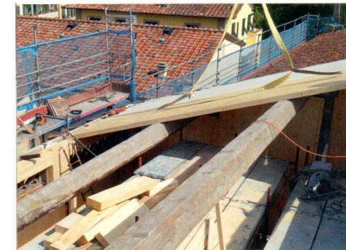
Abb. 15: ... Montage der Brettstapel-Dachelemente
