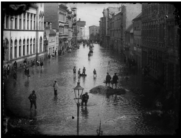
Stadtarchiv Forst: Forst (Lausitz), Berliner Straße während des Neißehochwassers 1897. Link
